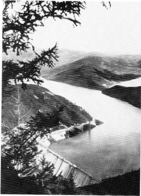
赴戦江発電所の建設 本巻の開書は、日本窒素肥料株式会社の手で、当時東洋一の規模となつた朝鮮赴戦江発電所がどのように建設されていったか、から始まる。
